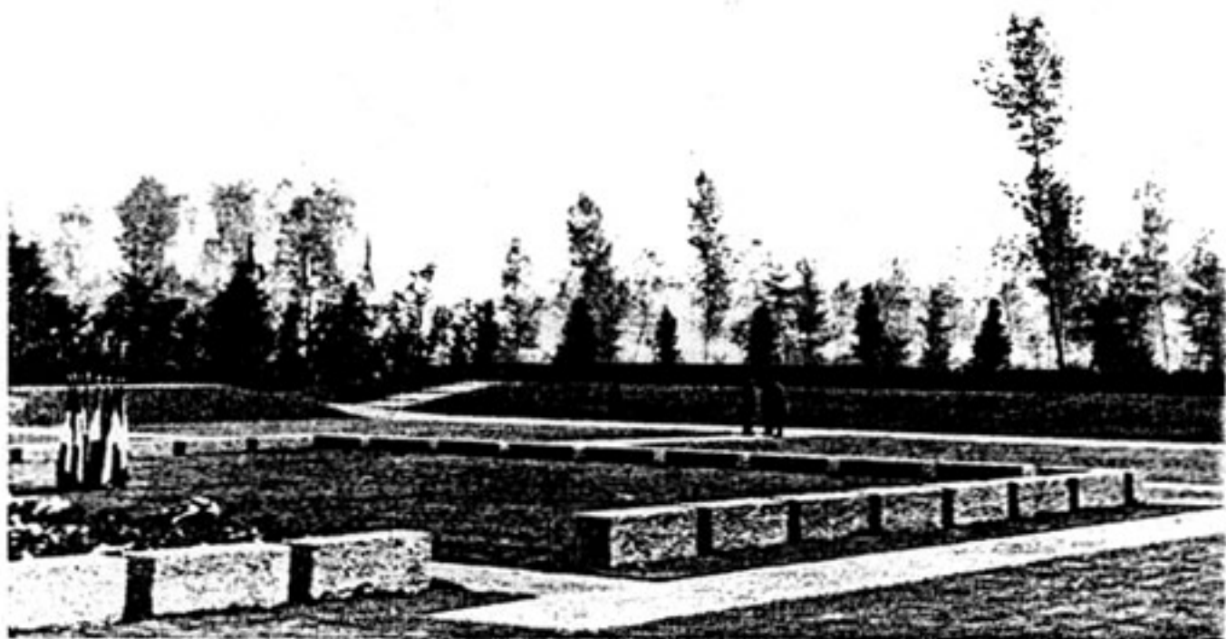
Particolare dell'area circondata da blocchi di cemento simbolici. (Fonte archivio Pietro Porcinai).
